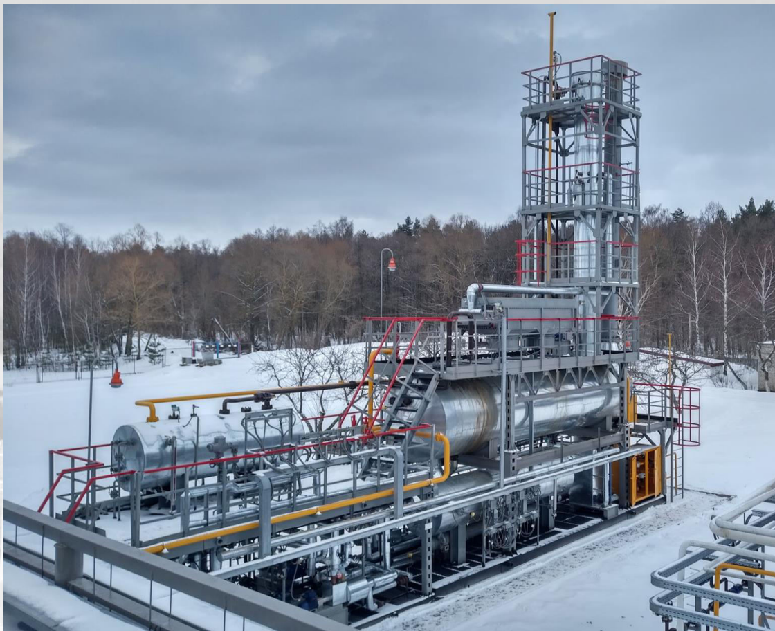
Блок регенерации диэтиленгликоля (триэтиленгликоля) на Червонопартизанском ПХГ
